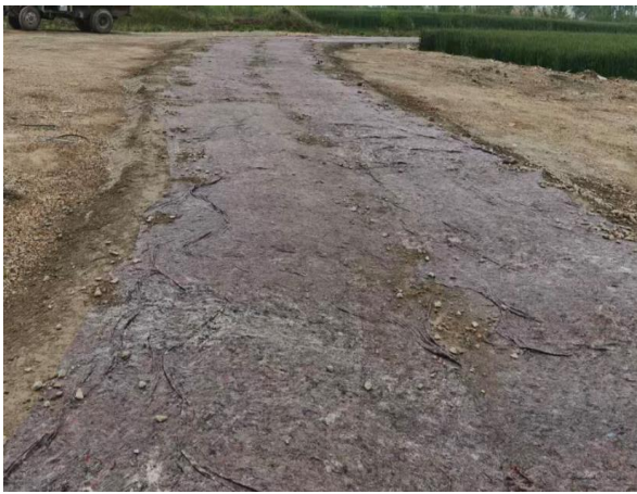
2#道路土工布苫盖 (2026 年 4 月)
