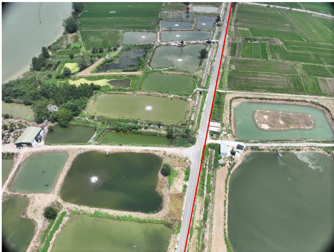
图 1.7 1#道路（扩建道路）现状（2026 年 7 月）
