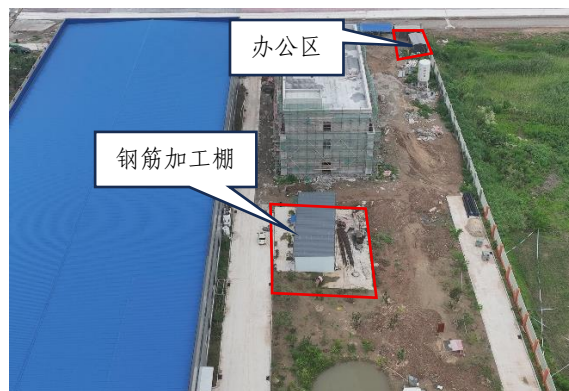
图 1.9 施工场地现状
