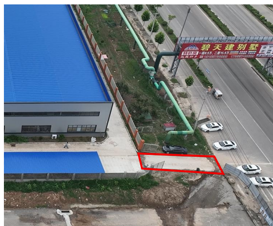
图 1.11 施工道路现状
