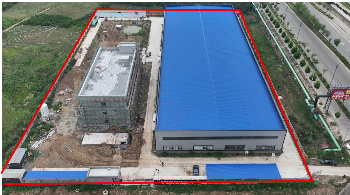
图 1.12 项目区建设现状（2026 年 6 月）
