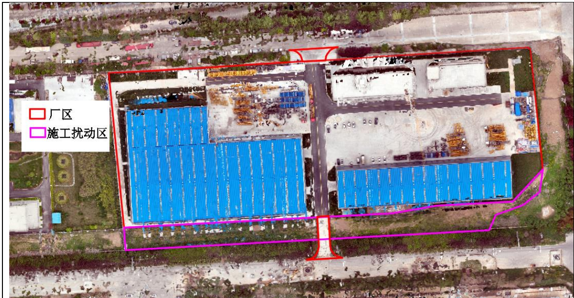
项目建设现状（2026年4月）
