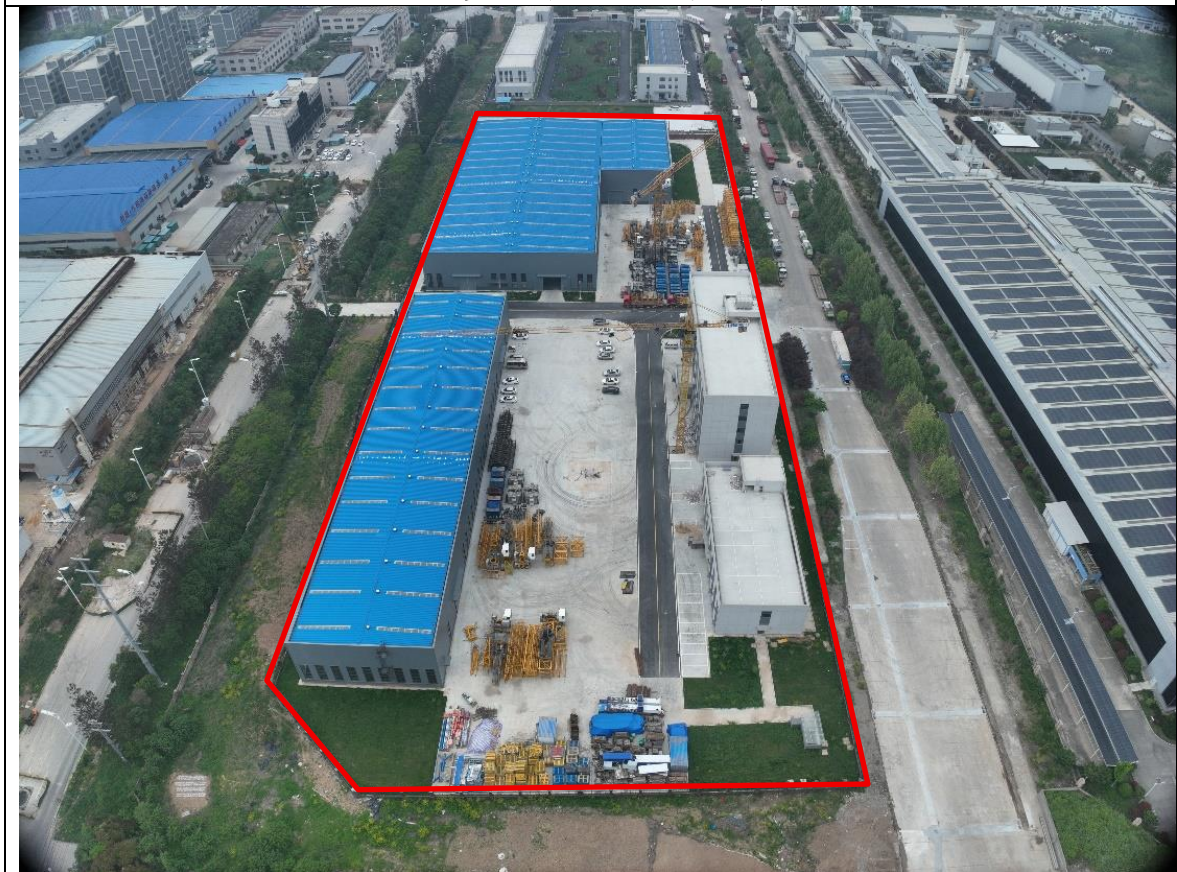
项目建设现状（2026年4月）
