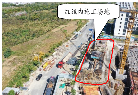
红线内施工场地 (2022.12)
