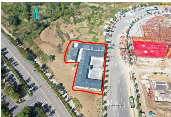
红线外施工项目部及生活区 (2022.12)
