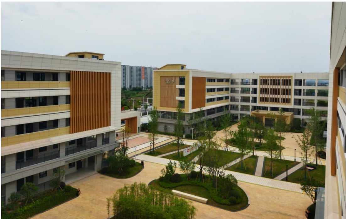
图 1.2.2 项目完工现状图
