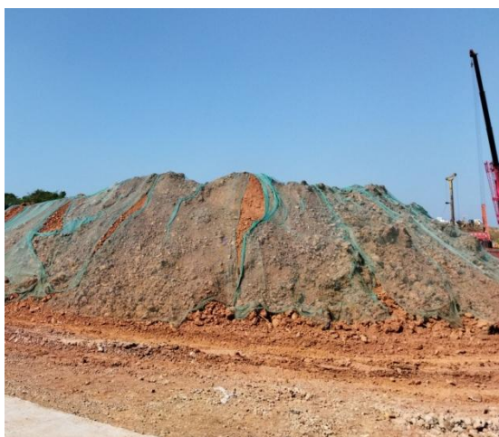
2024 年 9 月临时堆土情况
