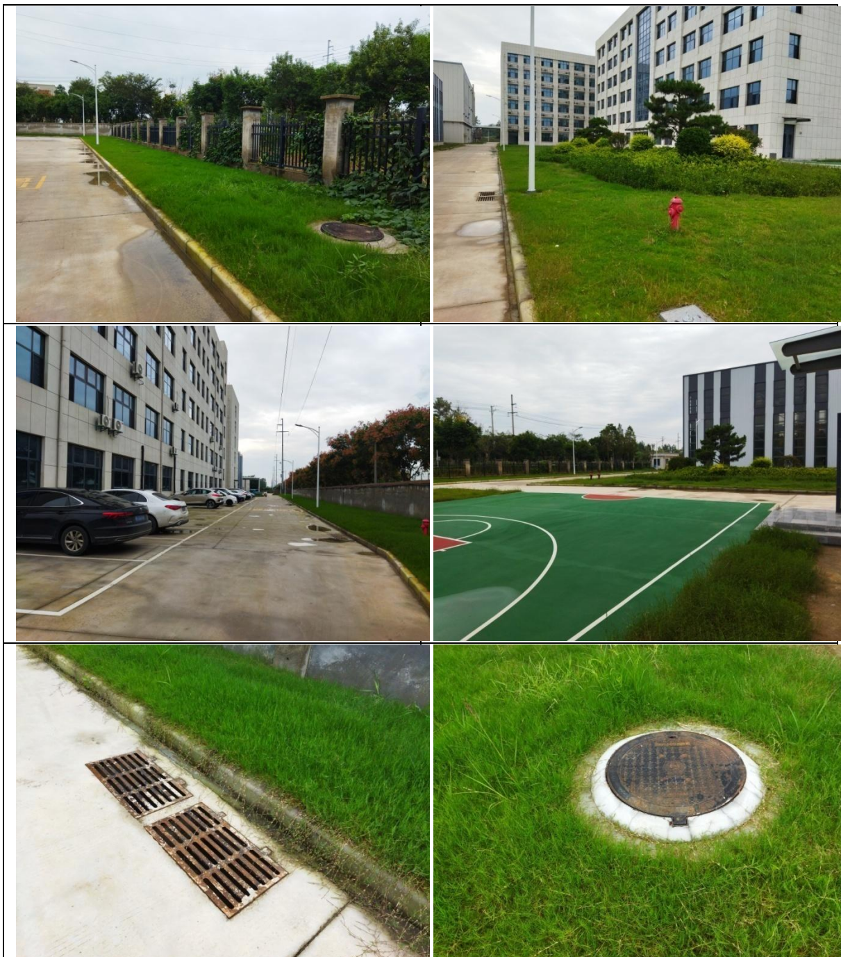
项目区排水、绿化照片（2025 年 9 月）
