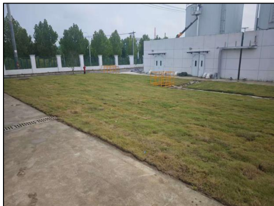
撒播草籽恢复（2025.9）
