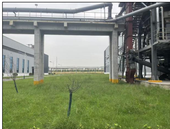
撒播草籽恢复（2025.9）
