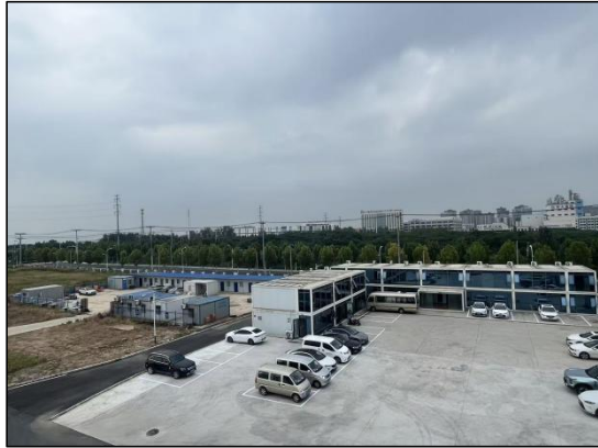
施工办公用房（2025.9）
