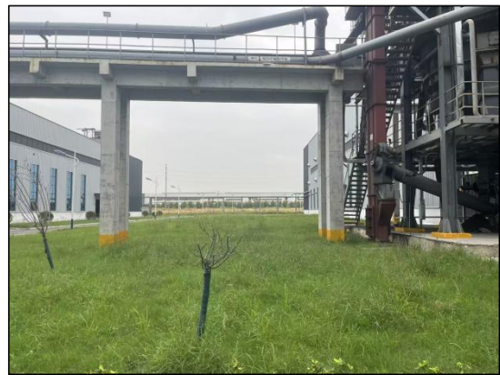
撒播草籽恢复（2025.9）
