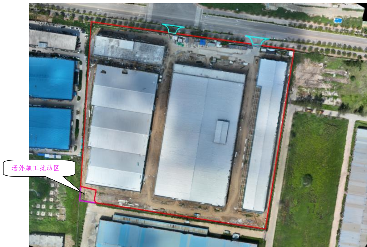
图 1.10 场外施工扰动现状（2025 年 8 月）
