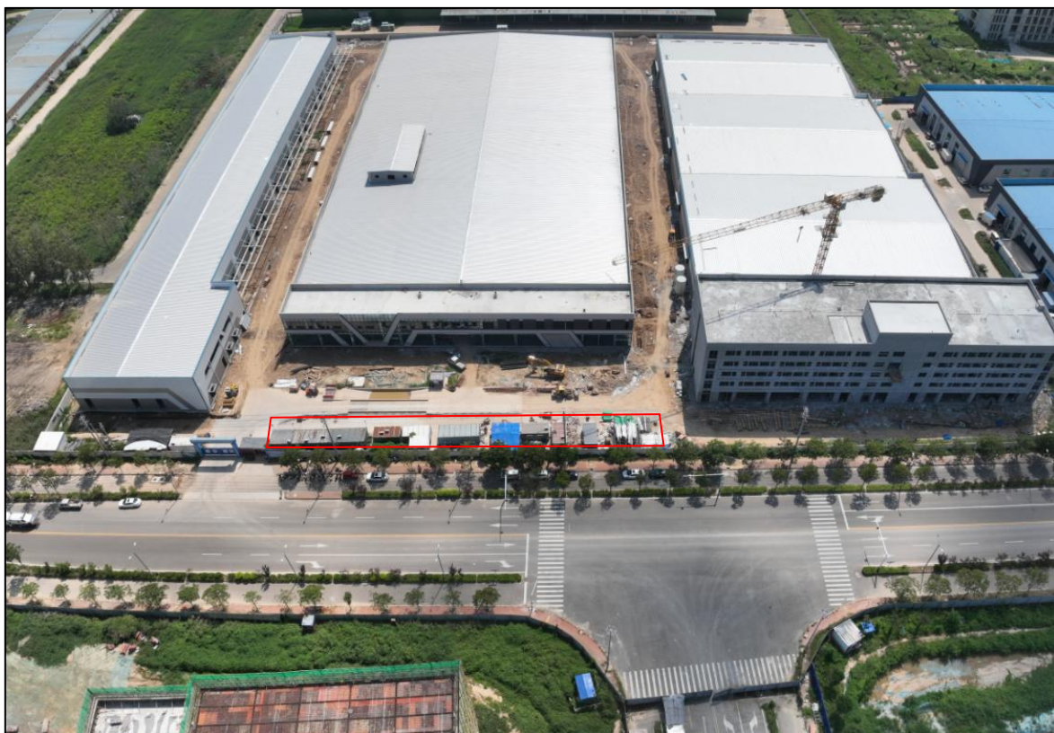
图 1.9 施工场地现状（2025.8）
