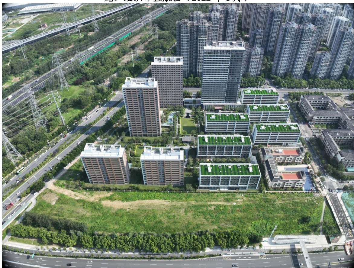
施工组织布置航拍（2025年6月）
