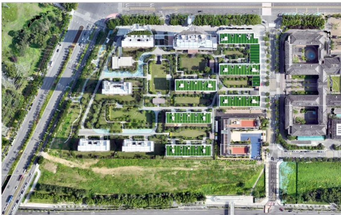
主体工程区建筑物航拍（2025 年 6 月）
