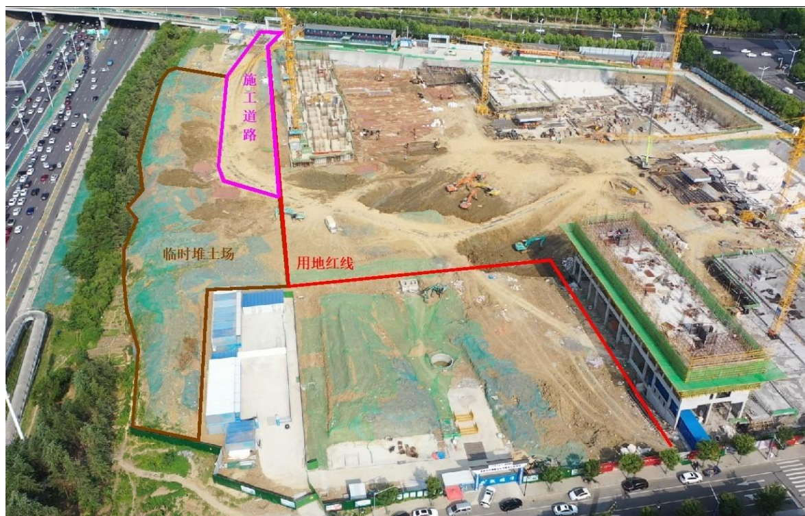
施工组织布置航拍（2022年8月）
