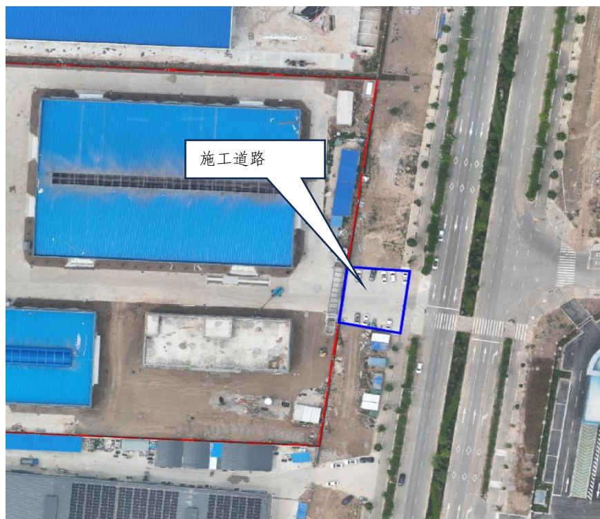
图 1.12 施工道路现状（2025 年 5 月）
