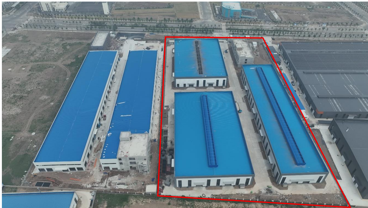
图 1.13 项目区建设现状 (2025 年 5 月)
