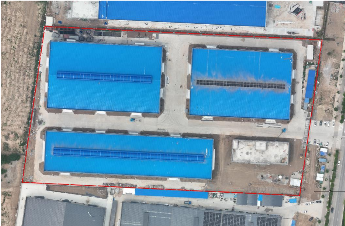
图 1.1 项目现状图（2025 年 5 月）
