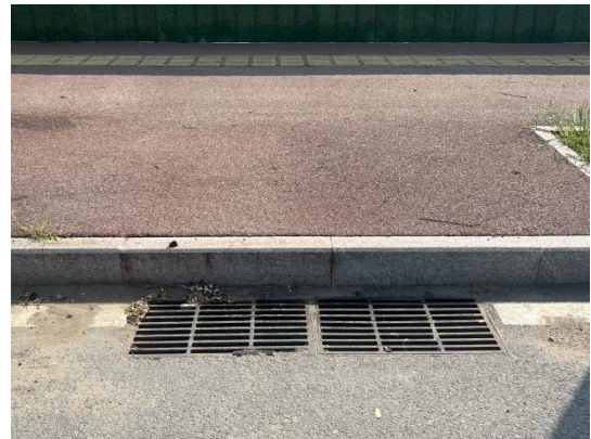
道路工程区雨水井 (2025.7)
