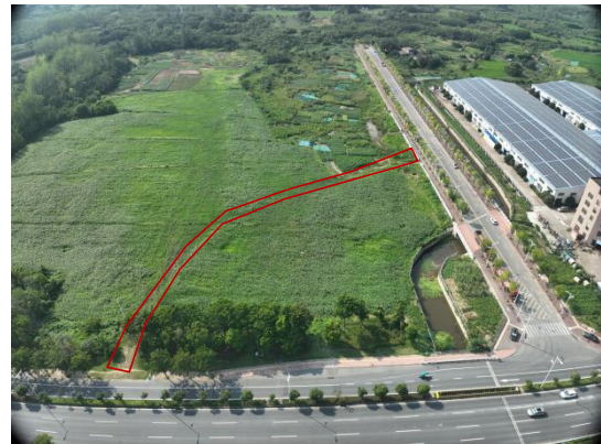
施工道路区撒播草籽 (2025.7)
