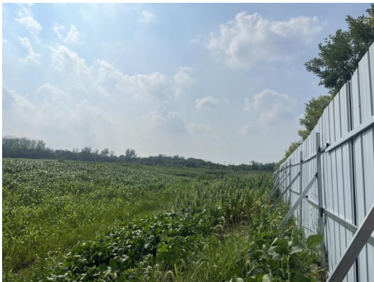
施工场地区撒播草籽 (2025.7)
