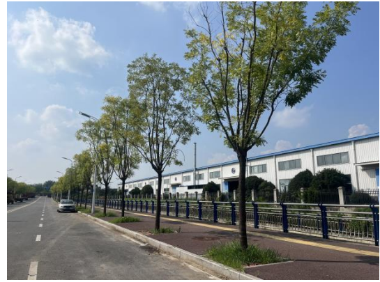
道路工程区绿化 (2025.7)
