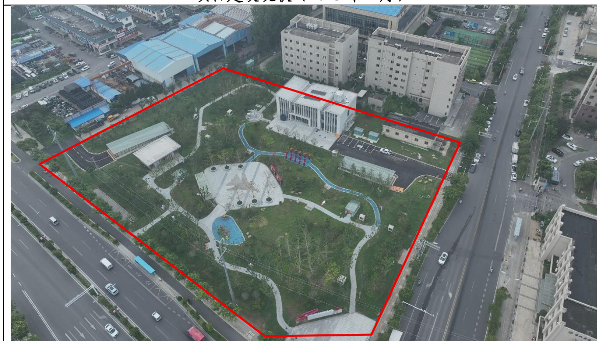
项目建设现状（2025 年 7 月）
