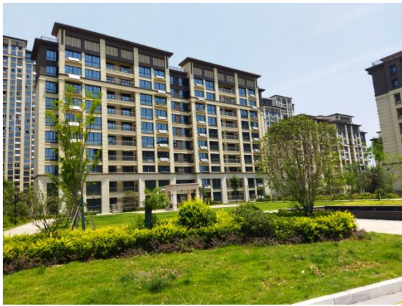
主体工程二区（2025.5）
