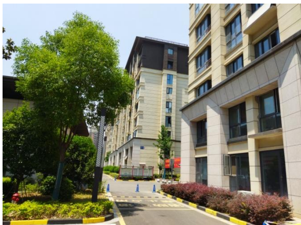
主体工程一区（2025.5）
