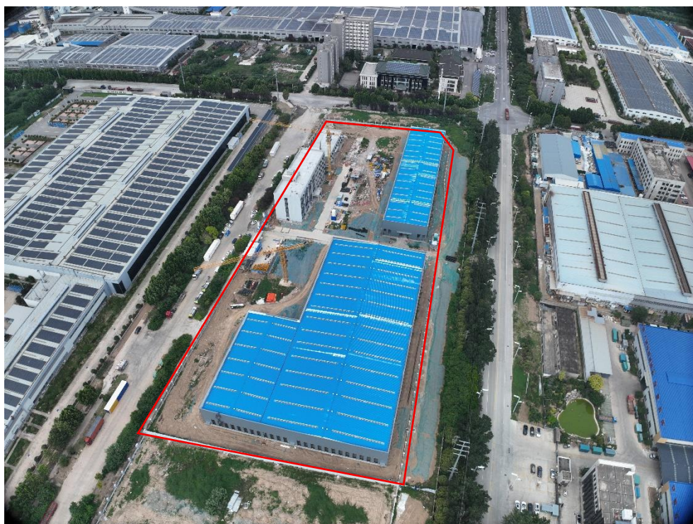
图 1.12 项目区建设现状（2025 年 6 月）
