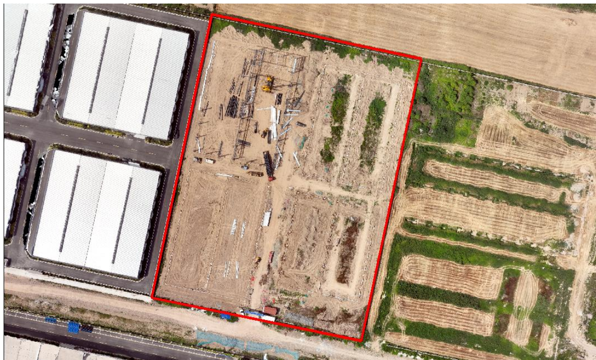
图 1.6 项目建设现状（2025 年 6 月）
