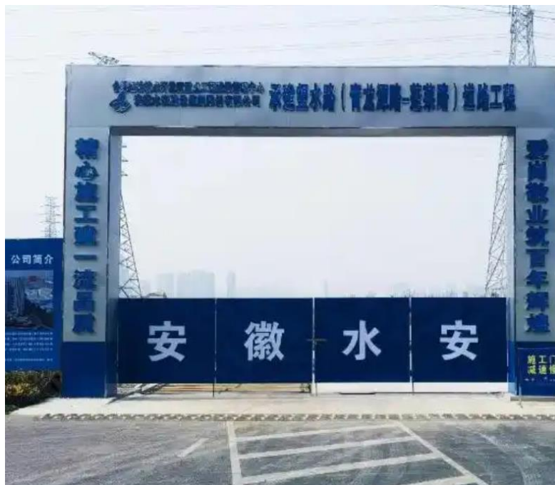
望水路（青龙潭路-蓬莱路）道路工程
