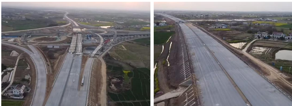
G4222 和县至襄阳高速公路肥西（丰乐）至舒城（千人桥）段现状
