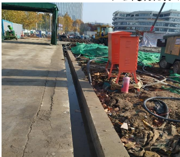
项目建设现状（2024年12月）
