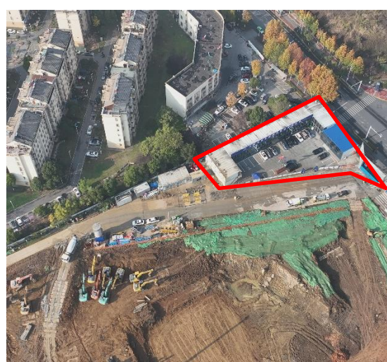
施工场地现状
