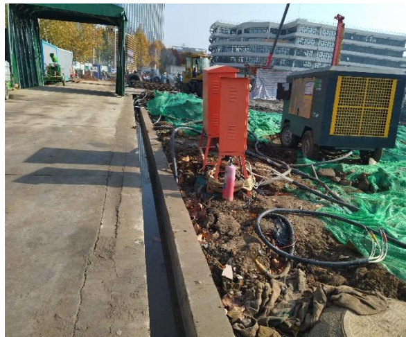
浆砌砖排水沟 (2024 年 11 月)
