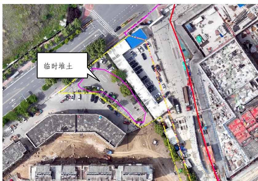
图 2.11 临时堆土场位置图（2025 年 5 月）
