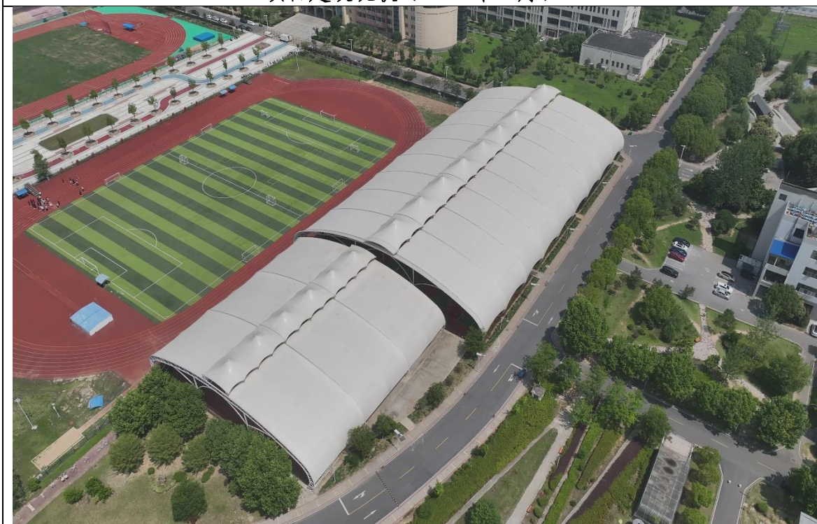
项目建设现状（2025 年 5 月）
