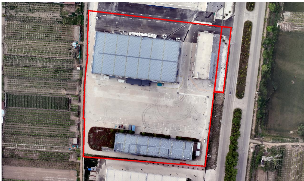
项目区排水、绿化照片及整体航拍（2025 年 4 月）
