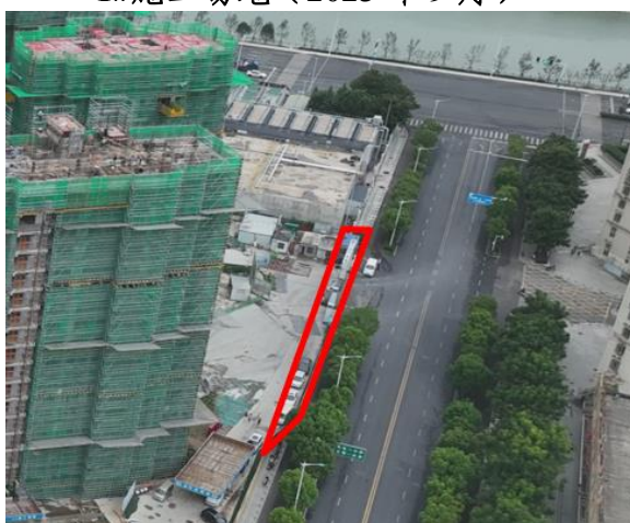
2#施工扰动（2023 年 9 月）
