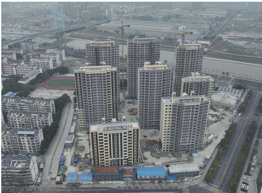
项目建设现状（2024年3月）
