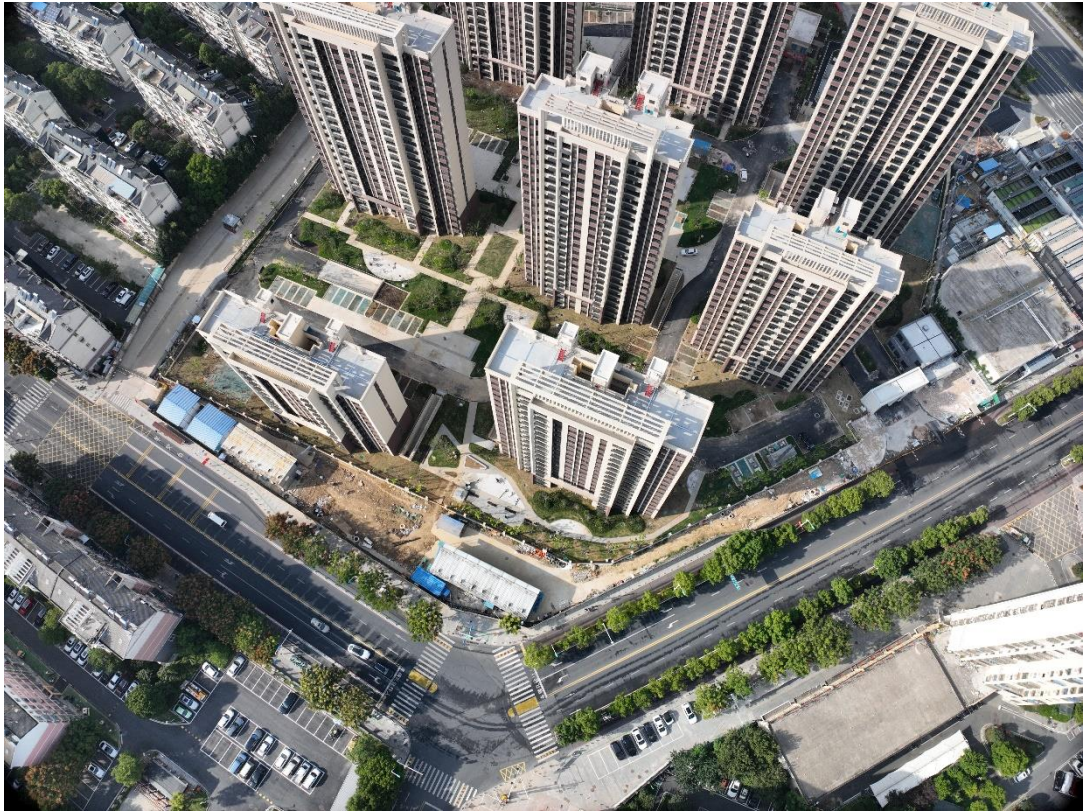
项目建设现状（2024 年 10 月）
