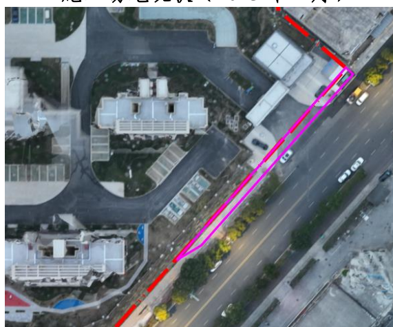
2#施工扰动现状（2025 年 2 月）
