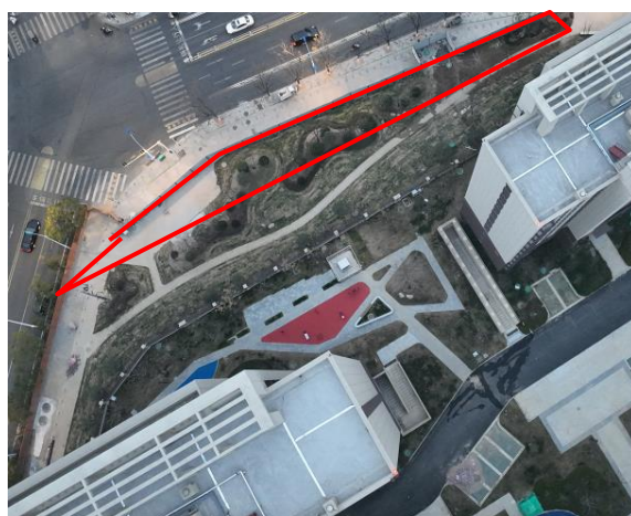
1#施工场地现状（2025 年 2 月）
