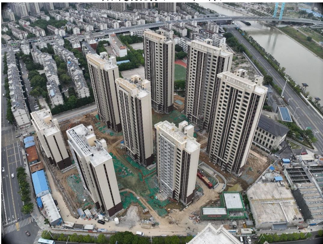
项目建设现状（2024年6月）
