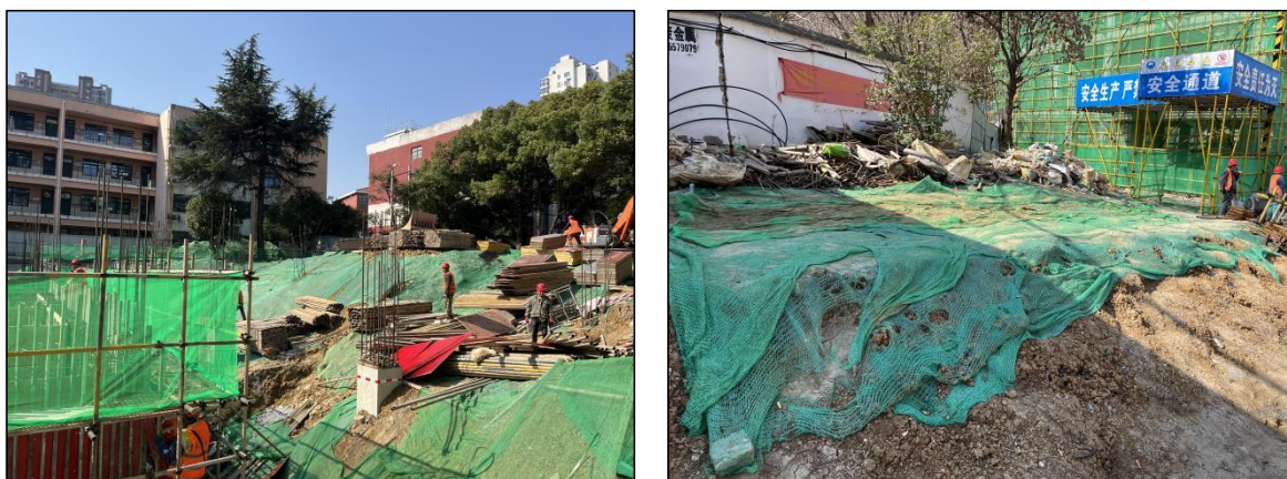
植被建设及密目网苫盖
