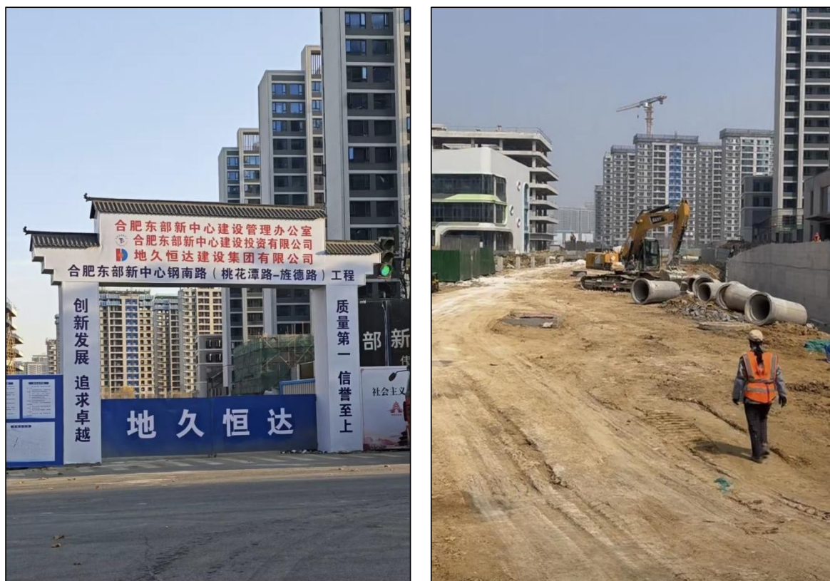
图 1.5-4 项目施工现状图
