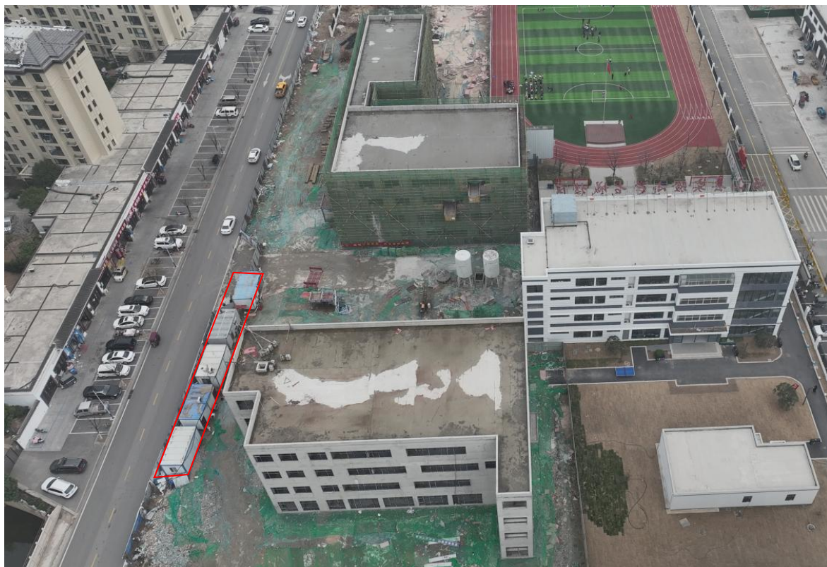
图 1.6 施工场地现状
