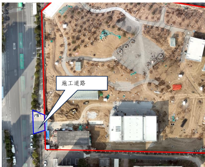
图 1.10 施工道路现状（2025 年 2 月）
