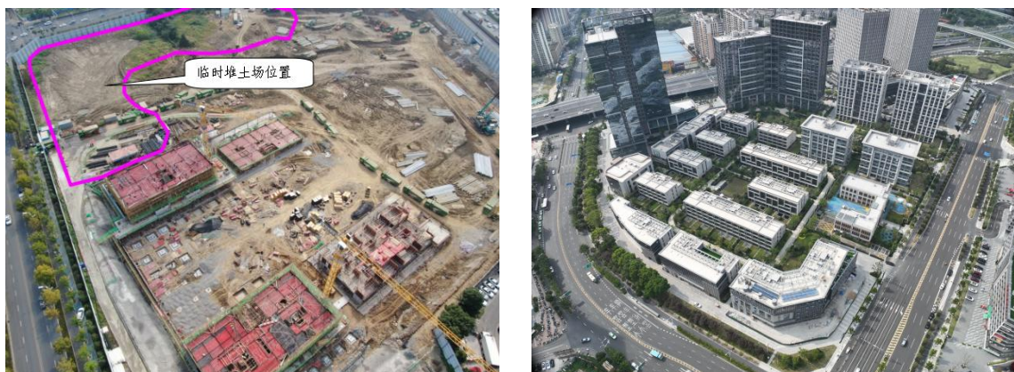
图 1.4 临时堆土场位置及现状图
