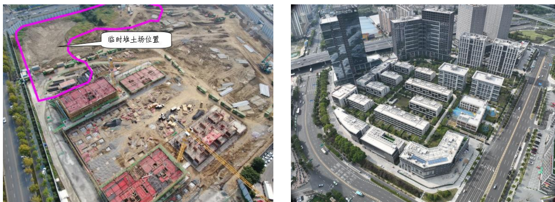
图 1.3 临时堆土场位置及现状图
