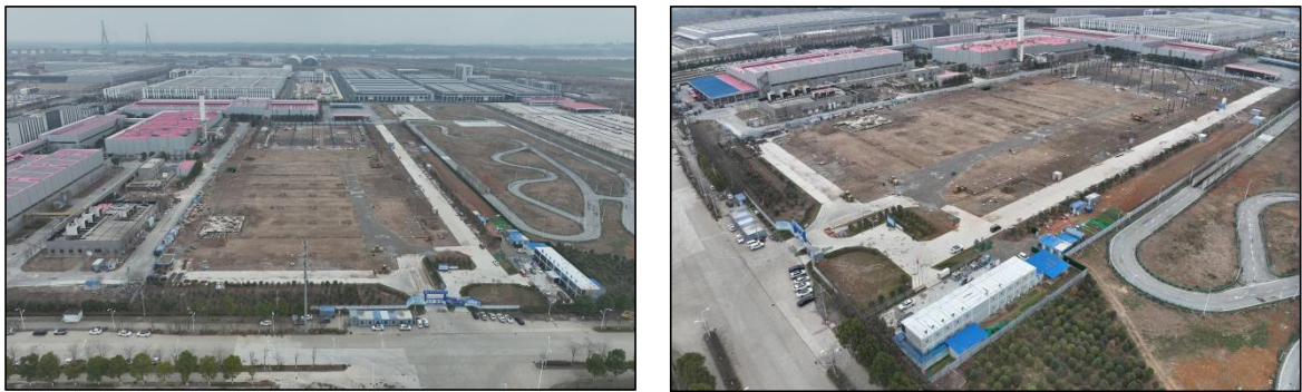
图 1.3-2 项目建设现状（2025.2）
