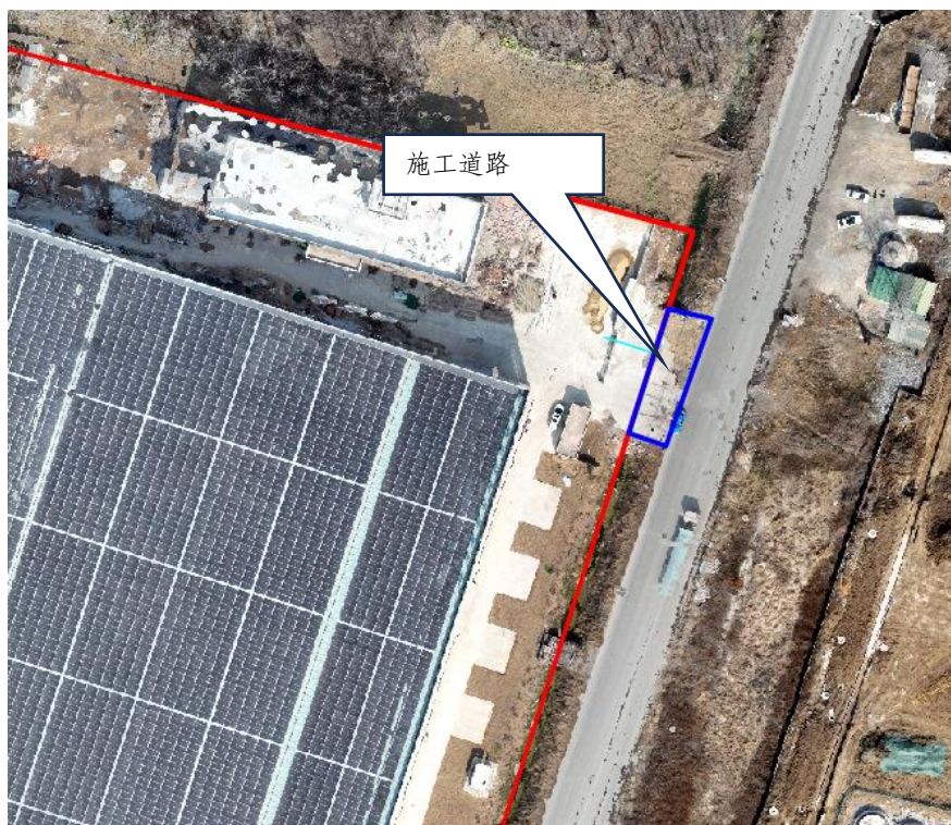
图 1.10 施工道路现状（2025 年 2 月）
