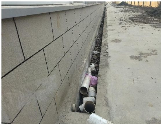
浆砌砖排水沟
