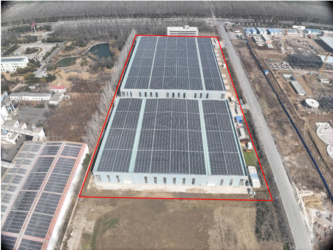
图 1.11 项目区建设现状（2025 年 2 月）
