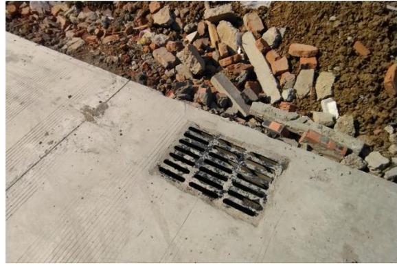
图 1.10 已建成雨水管线
