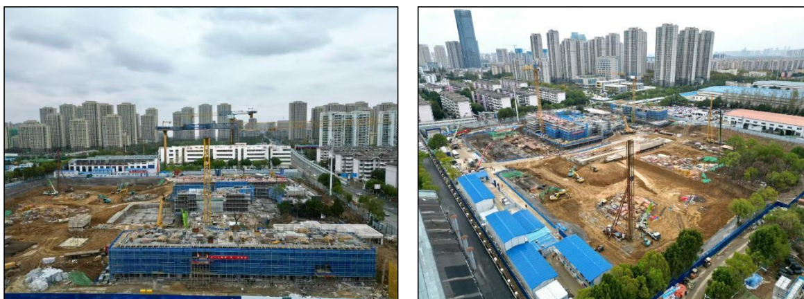
图 1.5-5 合肥邦成盛泰置业项目（BH202425 地块）施工现状图
