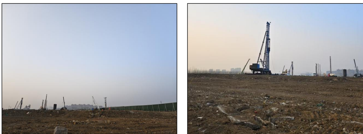
图 1.5-4 项目施工现状图
