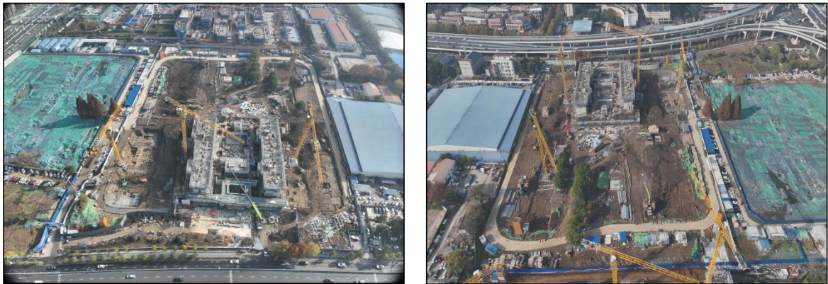
图 1.3-2 项目建设现状（2024.12）
