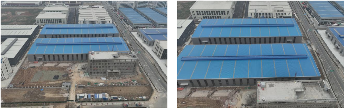
图 1.3-2 项目建设现状（2025.1）
