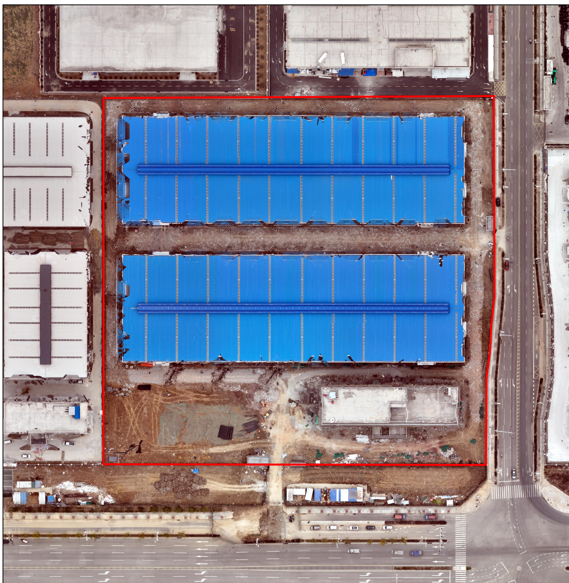
图 1.1-1 项目施工现状图（正射套红线 2025.1）
