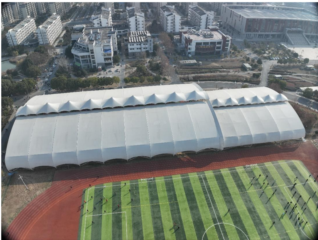
图 1.6 项目区建设现状（2024 年 10 月）
