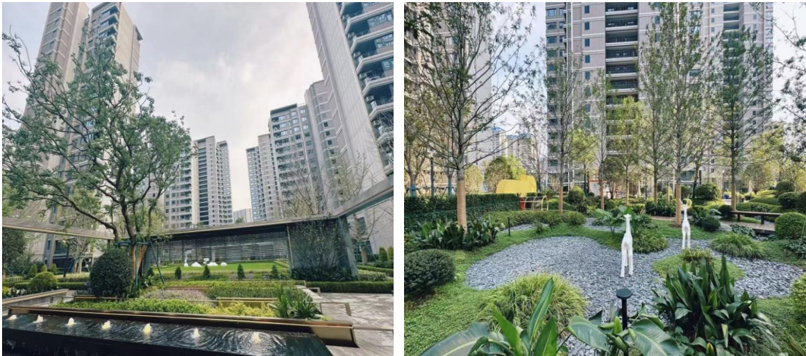
图 1.7 余方项目现场照片
