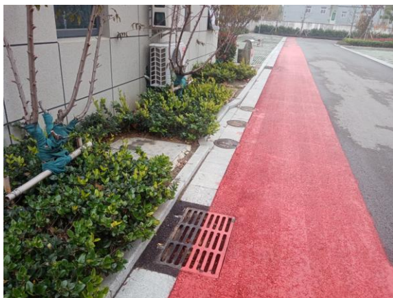
项目区内雨水口现状（2024.12）
