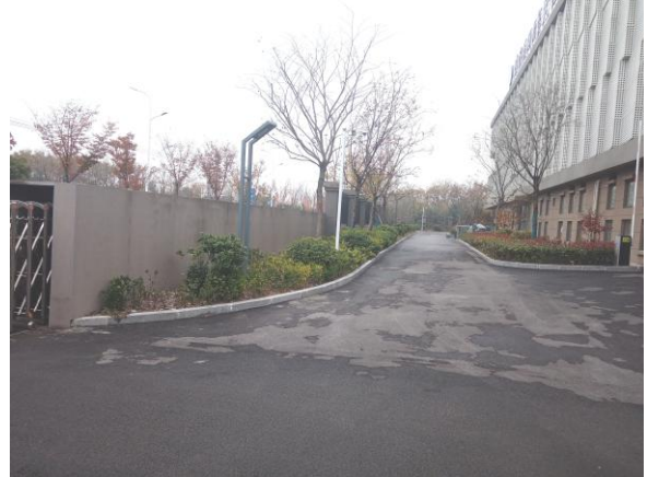
厂区内道路现状 (2024.12)
