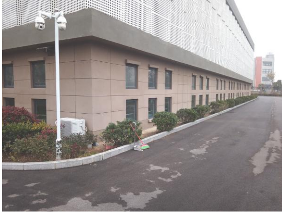
厂区内道路现状 (2024.12)
