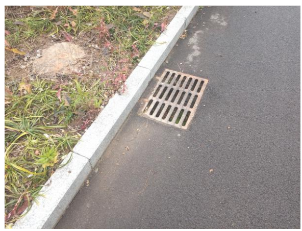
厂区内雨水口现状 (2024.12)
