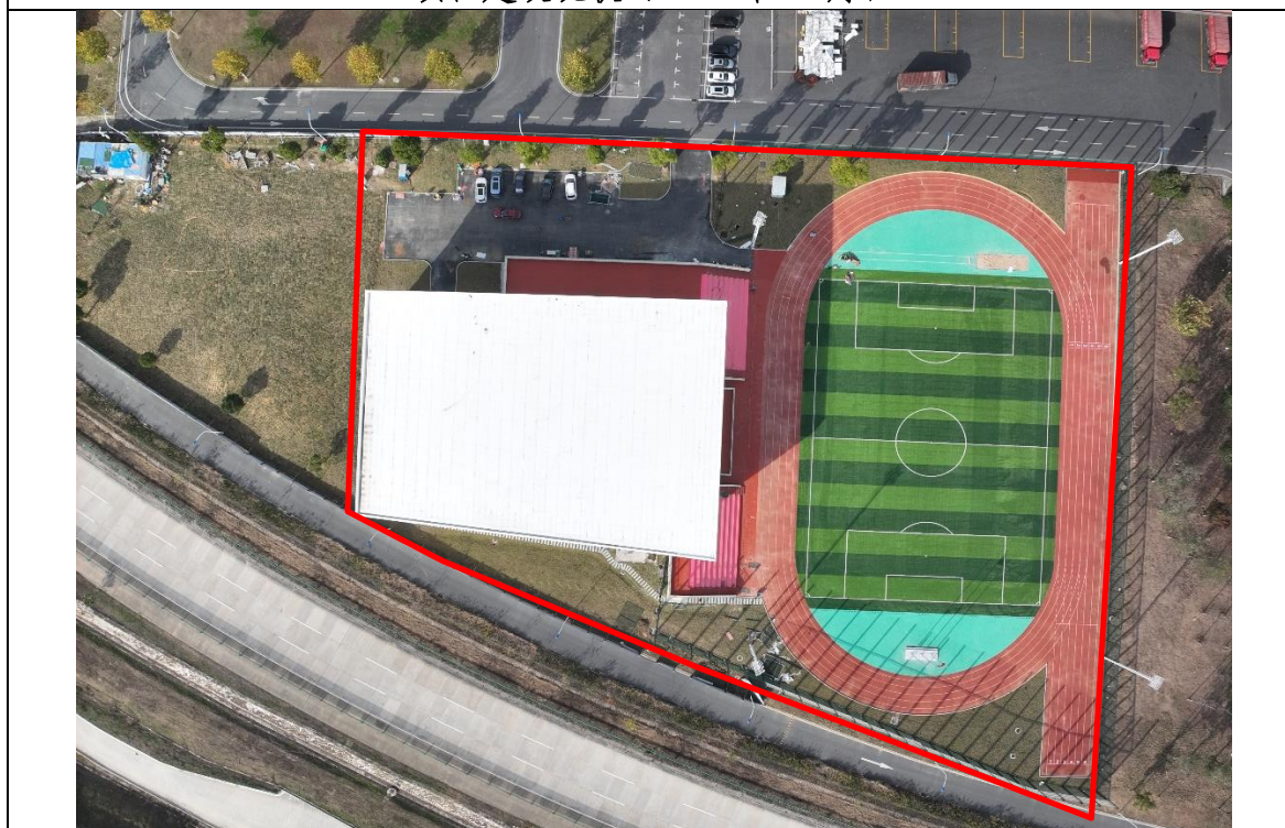
项目建设现状（2024 年 11 月）
