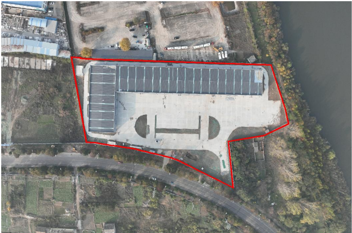
图 1.1 项目建设现状（2024 年 11 月）
