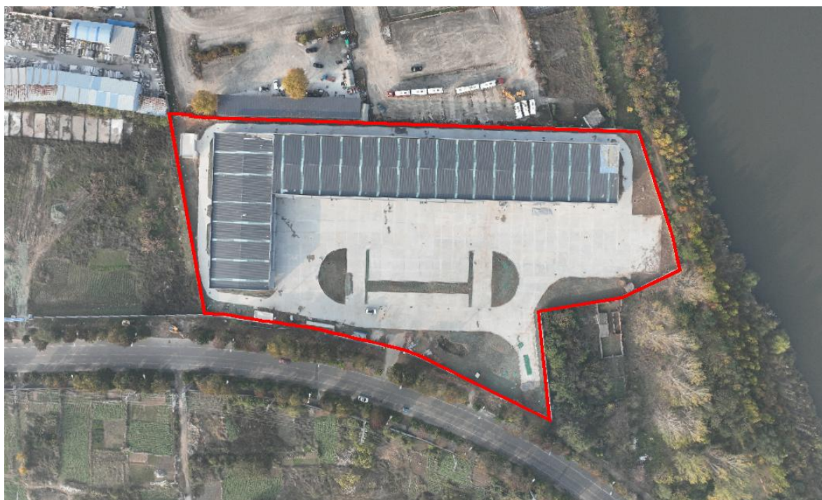
图 1.6 项目建设现状
