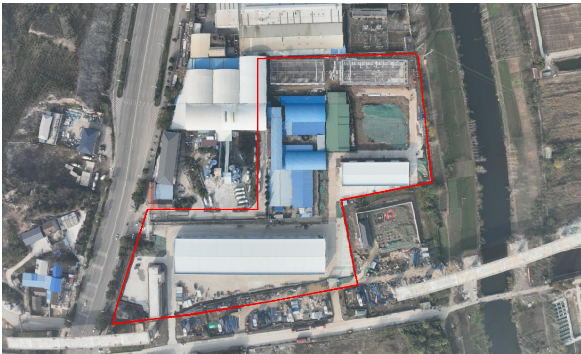
图 1.1 项目建设现状 (2024 年 11 月)
