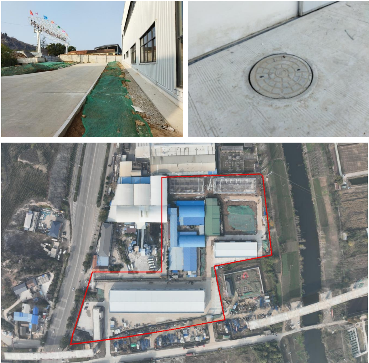
图 1.6 项目建设现状
