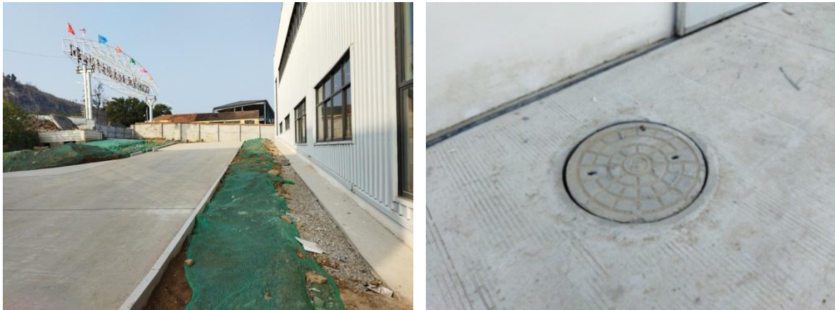
图 5.2 一期厂区已实施水保措施现场照片
