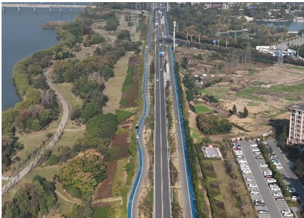
图 1.2 主体工程区航拍图（2023 年 12 月）
