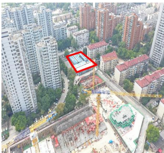
1#施工场地（2022年10月）
