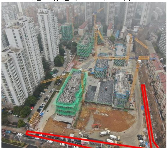
2#施工扰动（2022年10月）
