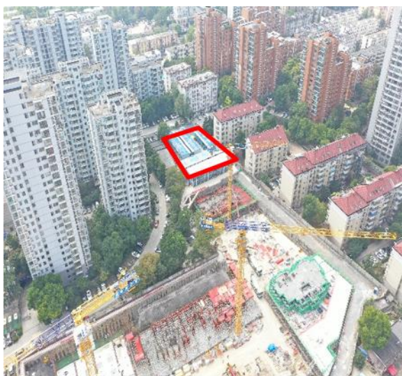
1#施工场地 (2022 年 10 月)
