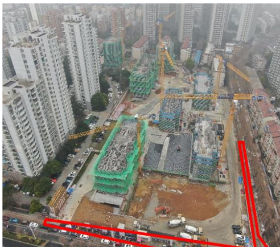
2#施工扰动（2022 年 10 月）
