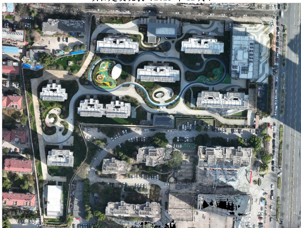
项目建设现状（2024 年 3 月）
