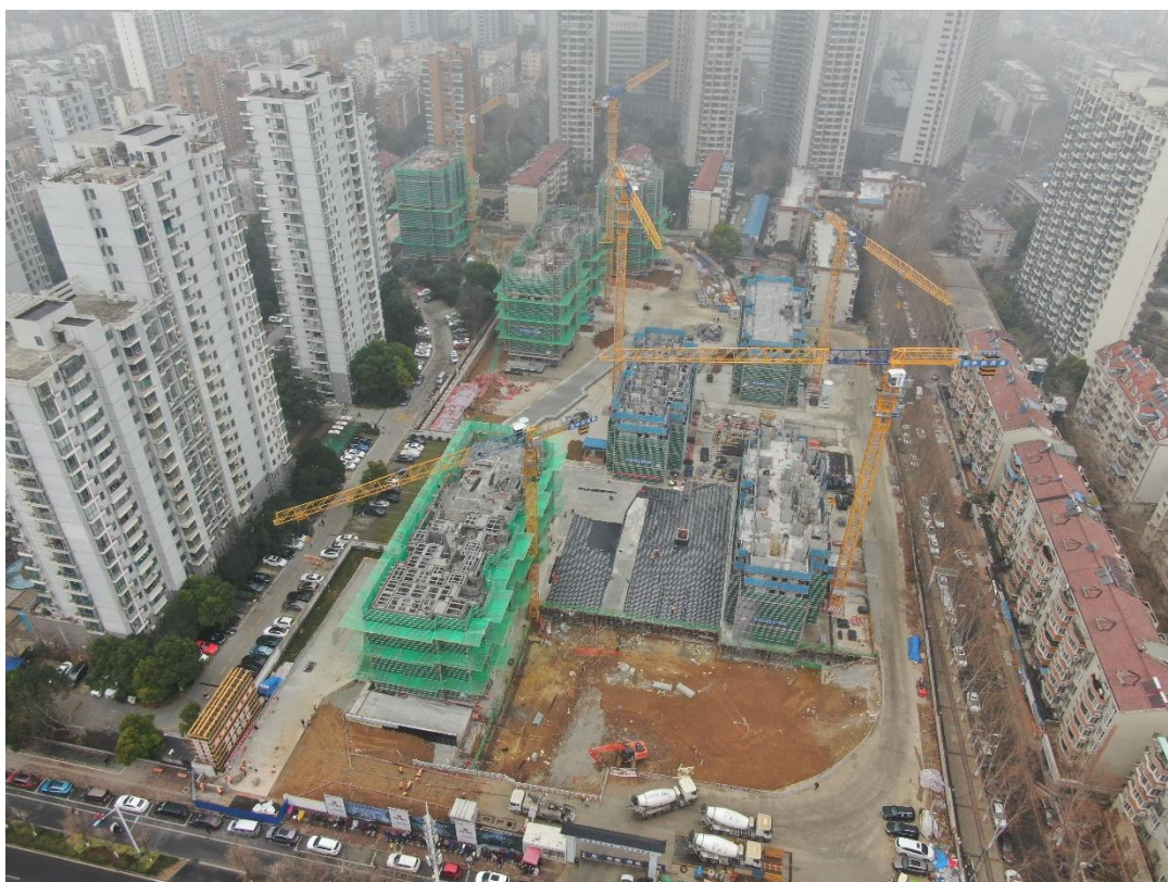
项目建设现状（2023 年 2 月）
