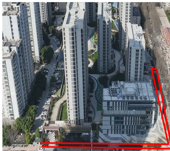
2#施工扰动（2024 年 3 月）
