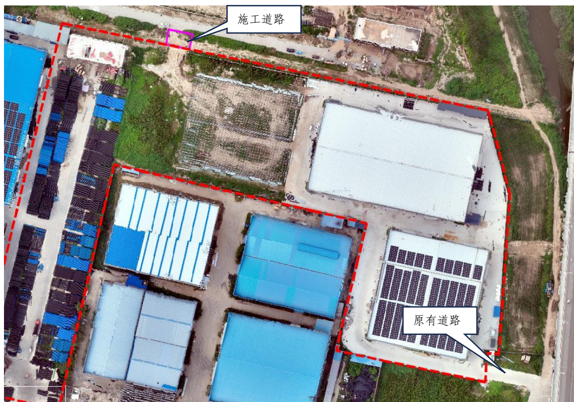
图 1.8 施工道路现状（2024 年 8 月）
