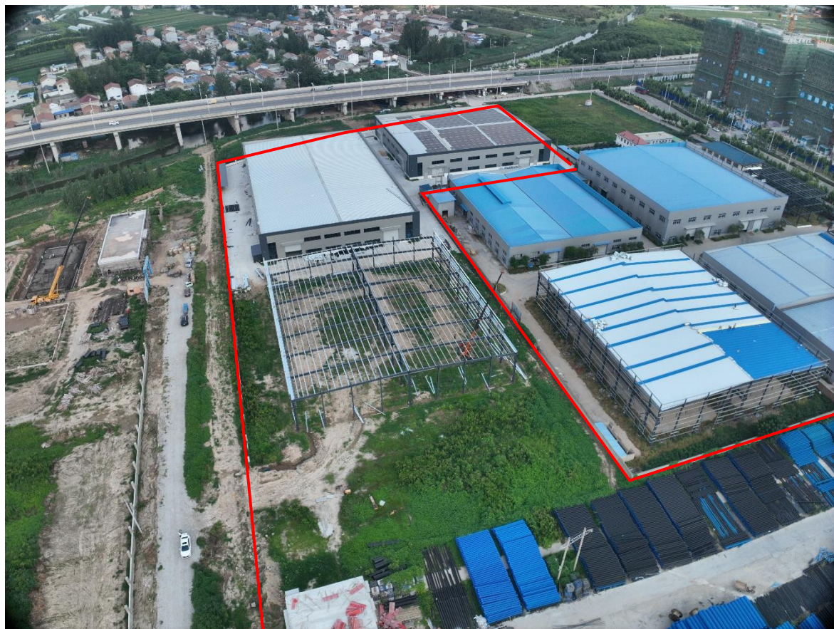
图 1.9 项目区建设现状（2024 年 8 月）
