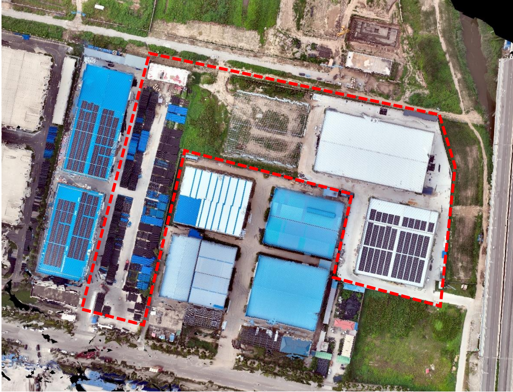
图 1.1 项目现状图（2024 年 8 月）
