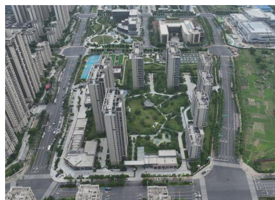
项目航拍图（D、E 地块）
