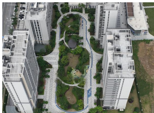
项目航拍图（B 地块）
