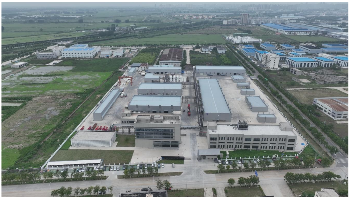
项目区排水、绿化照片及整体航拍（2024 年 7 月）
