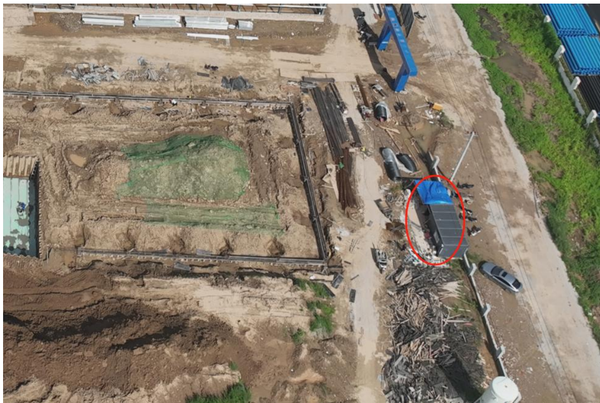
图 1.6 施工场地现状图
