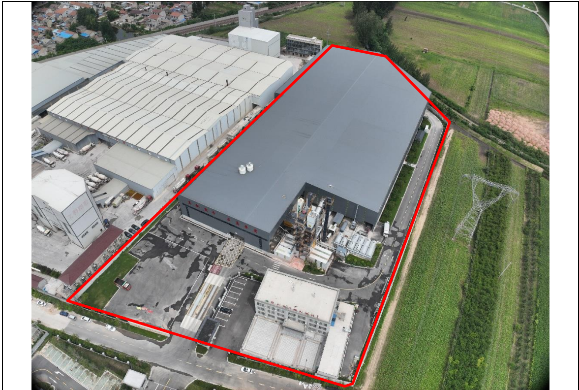
项目建设现状（2024年7月）
