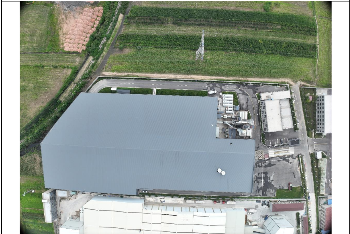
项目建设现状（2024年7月）
