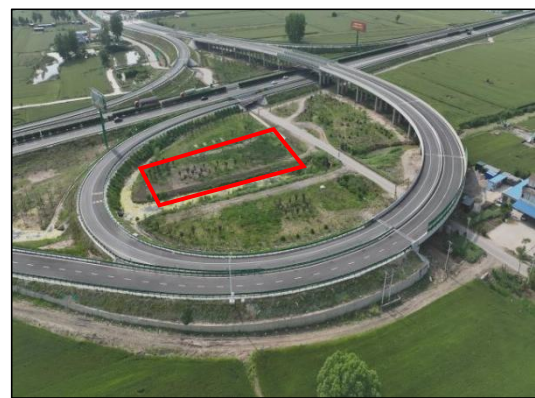
施工生产区现状（2024.5）
