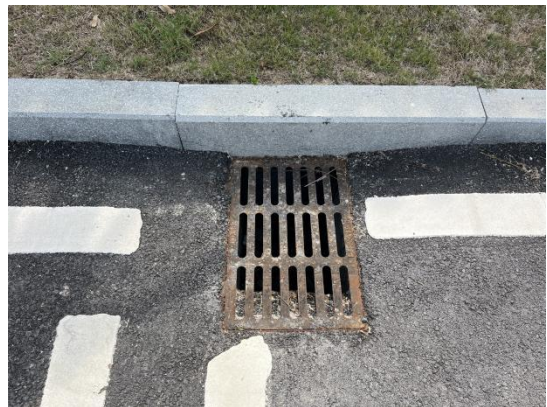
检查井（收费管理区）
