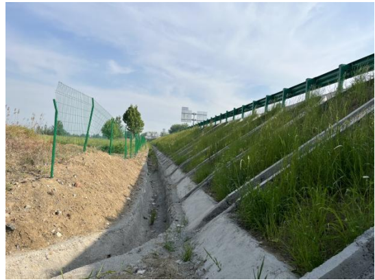
植草、排水沟（互通工程区）
