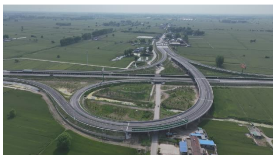
项目航拍图（互通工程区）
