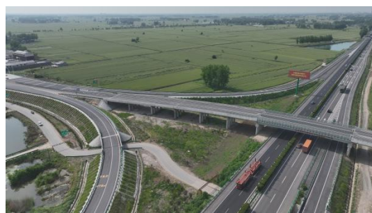
项目航拍图（互通工程区）
