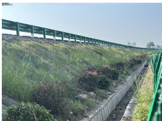
拱形骨架护坡、植草、排水沟 （互通工程区）
