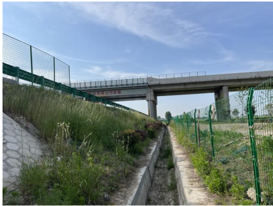
植草、排水沟（互通工程区）
