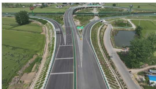
项目航拍图（互通工程区、改移工程区）
