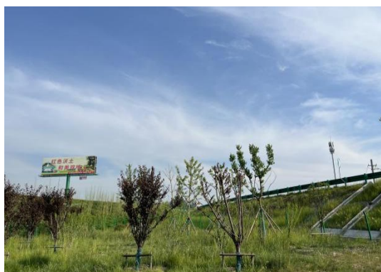
项目区绿化（互通工程区）
