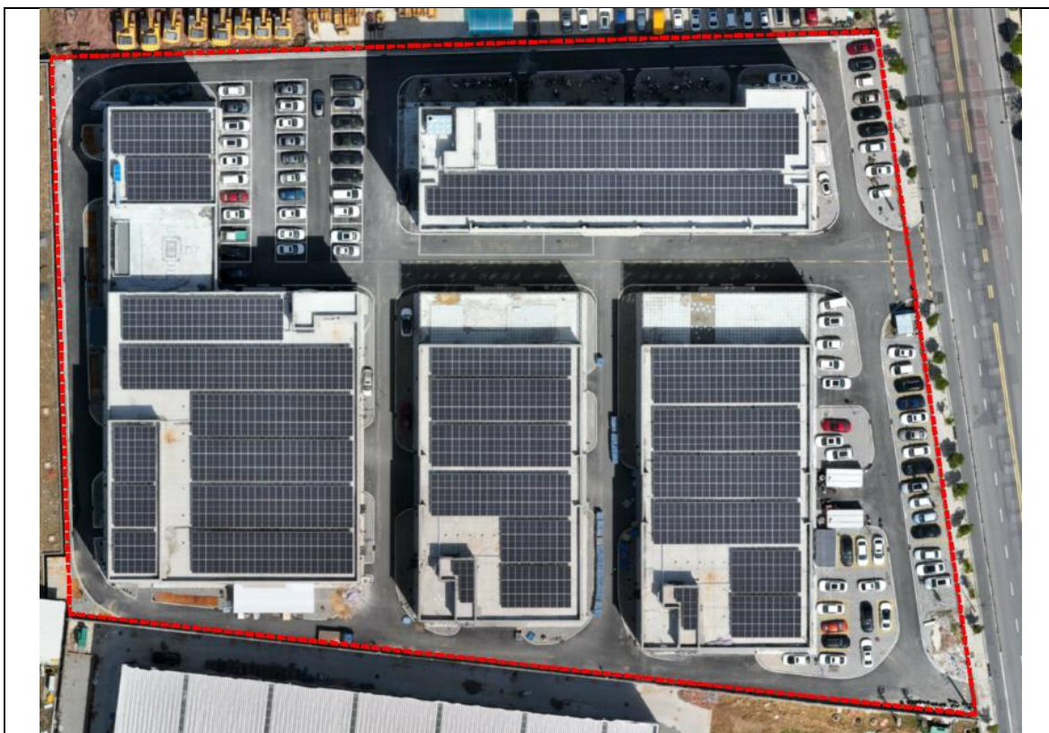
项目建设现状（2024 年 6 月）
