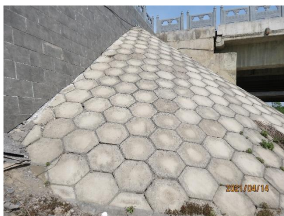
桥梁工程区混凝土护坡
