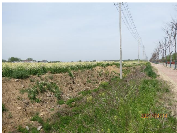
路基工程区土质排水沟
