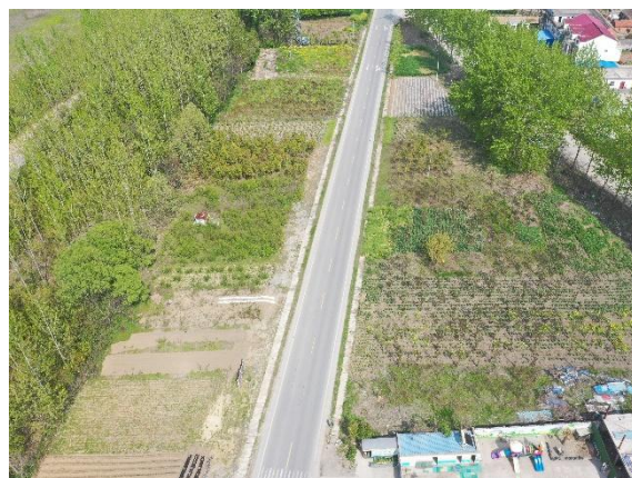
改迁建工程区 329 道路两侧盖板排水沟
