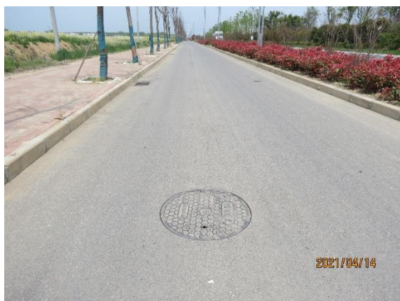
路基工程区雨水井
