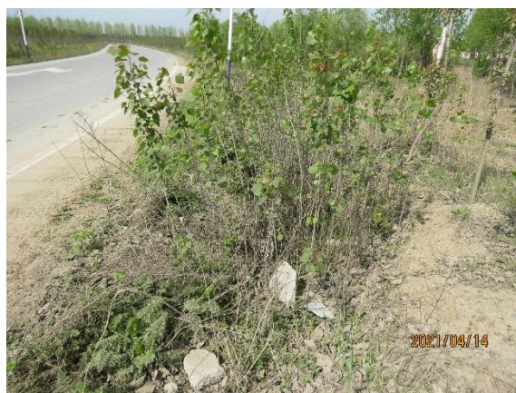
改迁建工程区土质排水沟
