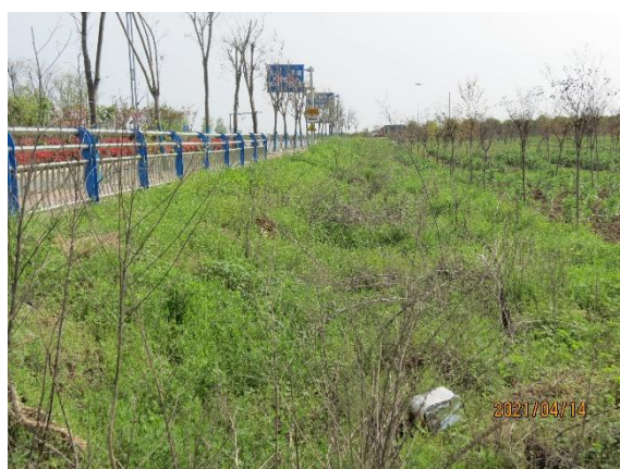
路基工程区边坡绿化
