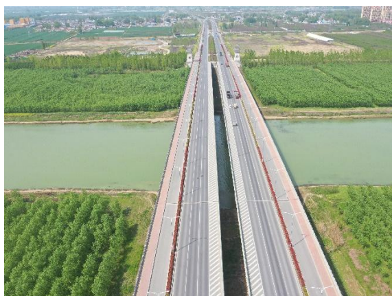
桥梁工程区绿化
