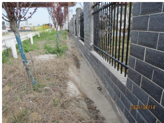
管护设施区混凝土排水沟
