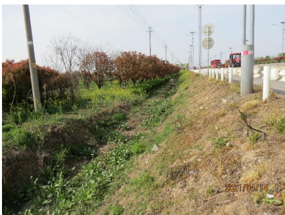
路基工程区土质排水沟
