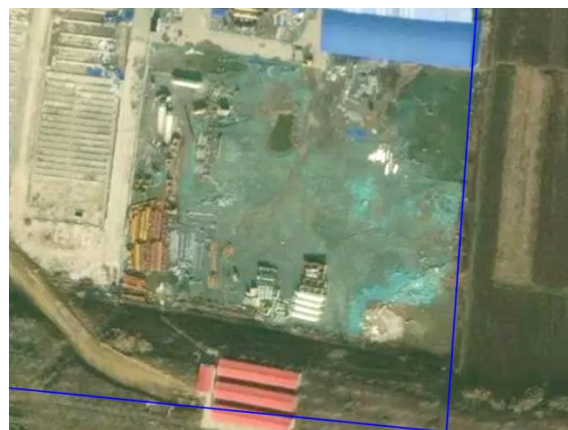
施工场地区对剥离表土进行密目网苫盖
