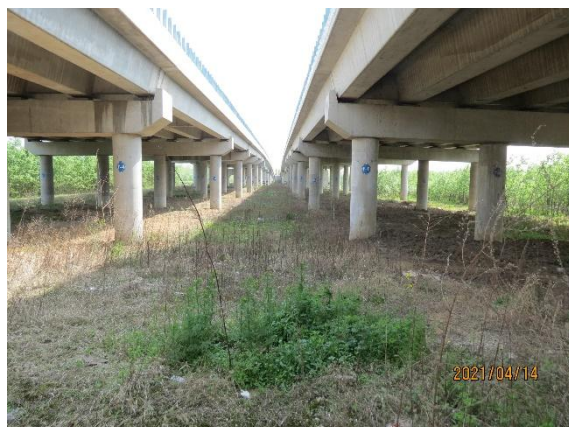
桥梁工程区绿化
