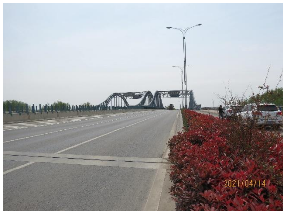
桥梁工程区绿化
