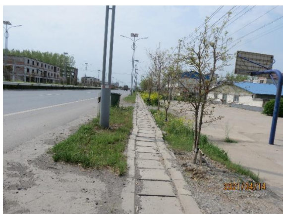
路基工程区盖板排水沟
