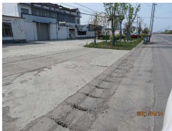
路基工程区盖板排水沟
